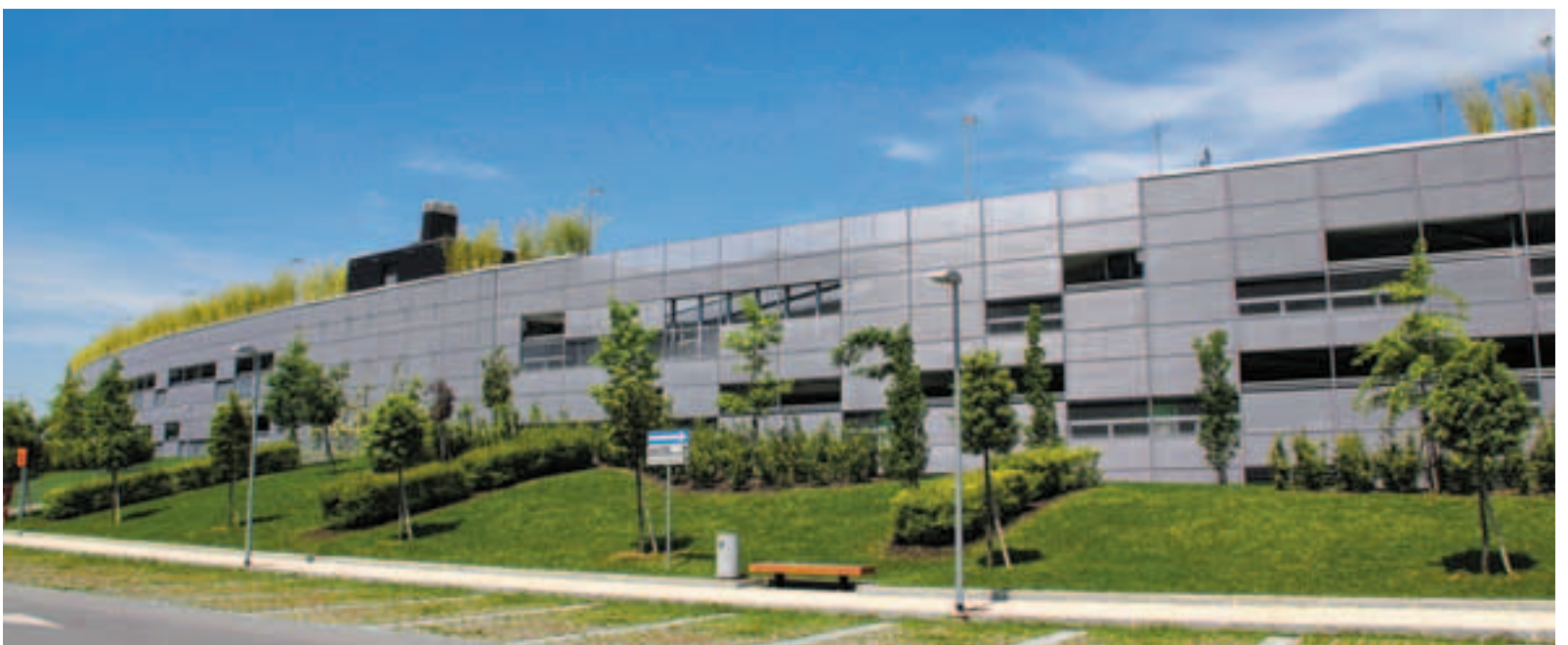
Il rivestimento in rete stirata garantisce il passaggio d'aria per il parcheggio multipiano, alleggerendo con la trasparenza l'impatto del rilevante volume.
