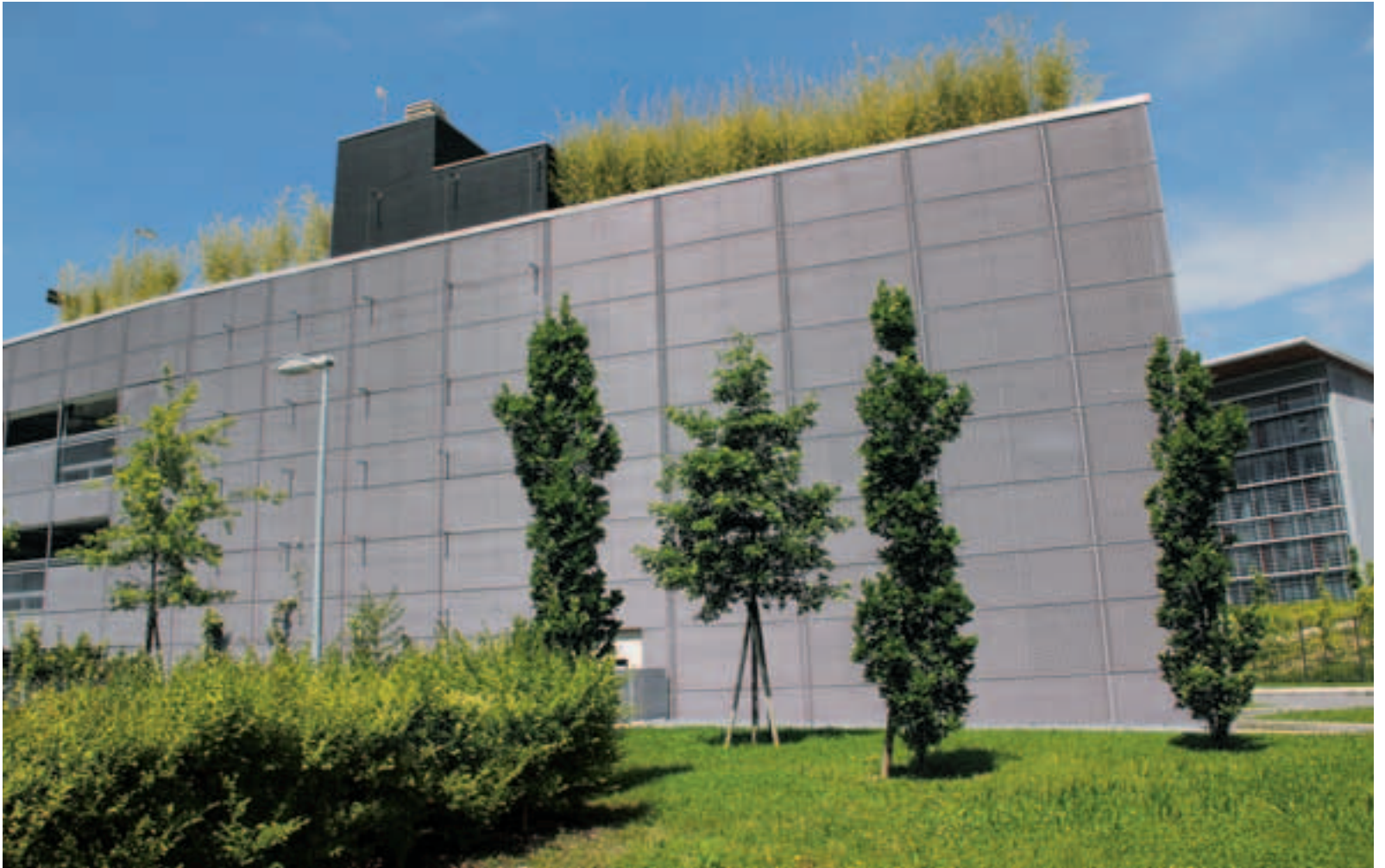
NUOVO OSPEDALE PAPA GIOVANNI XXIII - BERGAMO (Italia) Progetto: Studio Arch. TRAVERSI+TRAVERSI Rivestimento lamiera stirata: METALLTECH Foto: © Archivio Longhigroup
